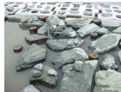
石と石の隙間にコンクリート注入↓
